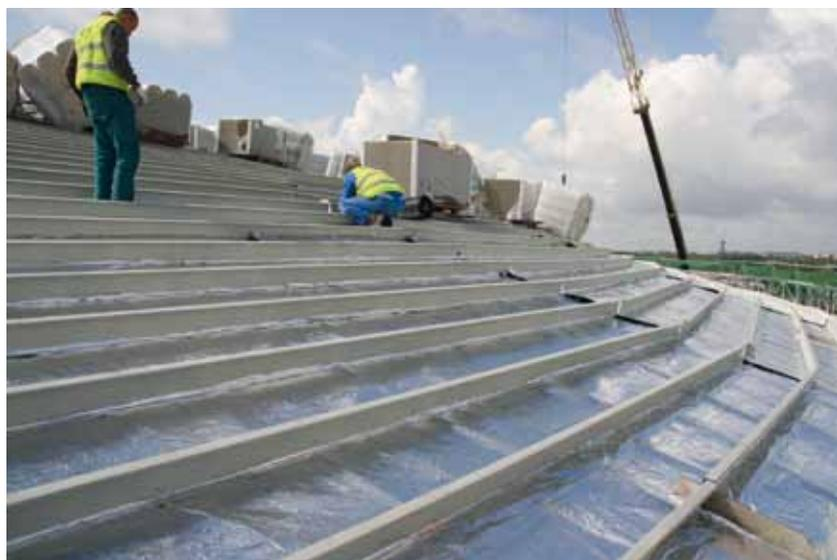
*La structure portante de la toiture a été réalisée avec des caissons perforés, remplis ensuite par de la laine de verre pour des raisons acoustiques.*
