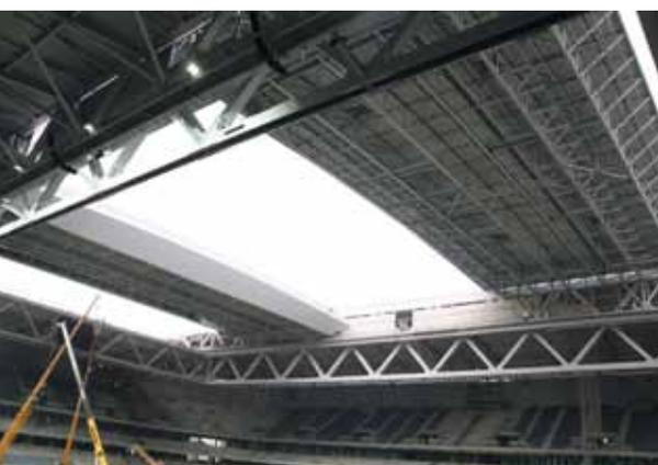
Pour la construction des poutres de support et de la charpente métallique des éléments de toiture ouvrants, on a utilisé plus d'acier que dans la Tour Eiffel.
