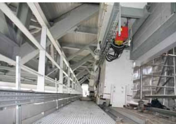
Une vue sur les roues qui font glisser les éléments de toiture sur les poutres
