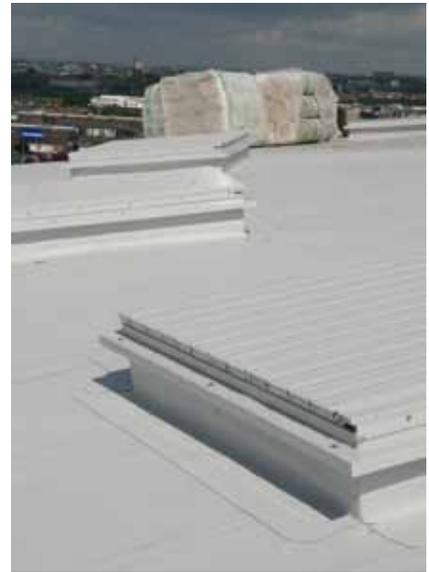
Malgré la toiture amovible, les coupoles EFC nécessaires ont été installées.
