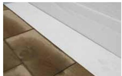
La membrane d'étanchéité en PVC a été appliquée après le géotextile.
