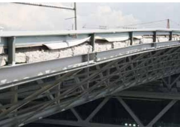
8500 m<sup>2</sup> de bardage ont été mis en œuvre, partiellement avec des panneaux sandwich, comme ici aux côtés des parties de toiture mobiles. ▲ avant ▼ après
