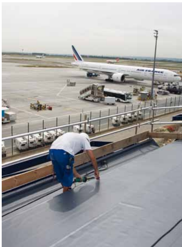
©Vincent Piront : Om de piloten niet te verblinden werd er geopteerd voor een grijze PVC dakbedekking.
