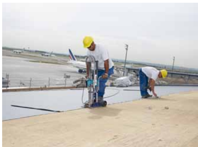
©Vincent Piront - Om het uitzicht uit de controletoeren niet te hinderen, mocht het afgewerkte dak geen centimeter hoger zijn dan voorgescreven in het bestek.
