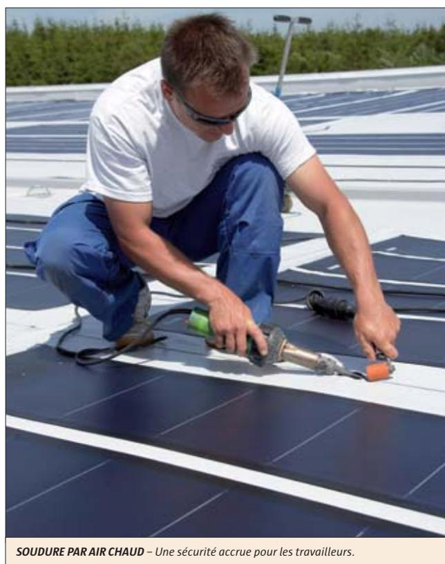
**SOUDURE PAR AIR CHAUD** – Une sécurité accrue pour les travailleurs.
