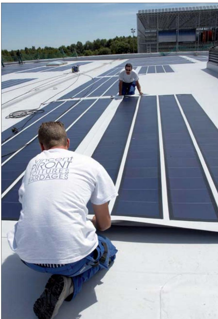
**MEMBRANES INTÉGRÉES** – Elles sont en PVC armé de fibres de verre et comportent quatre bandes photovoltaïques montées en usine.
