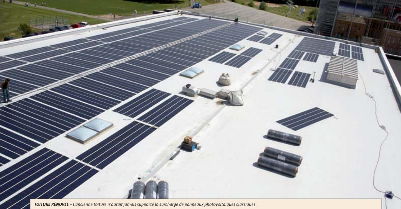
**TOITURE RÉNOVÉE** – L'ancienne toiture n'aurait jamais supporté la surcharge de panneaux photovoltaïques classiques.
