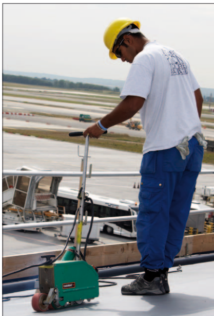
GARDE-CORPS – Près de 3 km ont dû être placés pour assurer la sécurité pour l'ensemble des corps de métier actifs en toiture.
