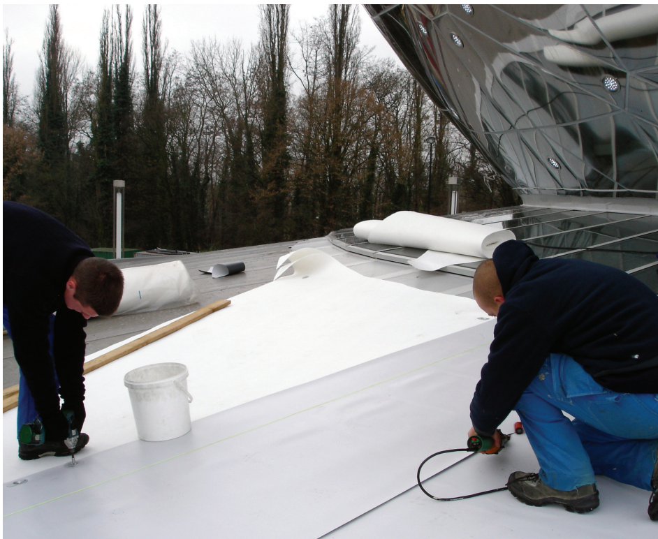
De conisch gesneden dakfolie werd in de overlapzone mechanisch bevestigd, waarna de overlappingsen met hete lucht werden dichtgelast.
