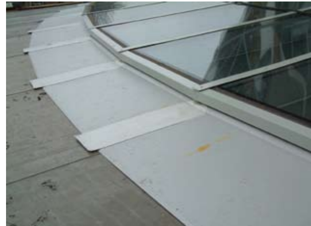
De aansluiting tussen de oude dakbedekking en de beglazingsprofielen werd gerealiseerd met behulp van gegalvaniseerde metalen platen die bekleed zijn met PVC folie.
