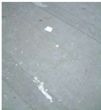
De oorspronkelijke PVC dakbedekking lag er nog relatief goed bij maar werd tijdens de werken behoorlijk beschadigd door neervallende schroeven, stukken metaal, werktuigen, lijm- en siliconenresten, enz...
