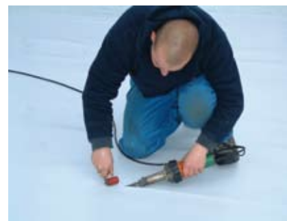
De overlappen tussen de conisch gesneden PVC banen werden met hete lucht dichtgelast.
